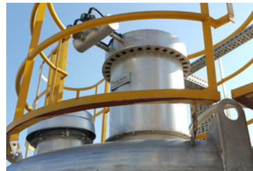
Siloaufsatzfilter
